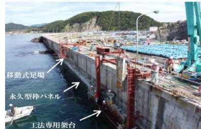
様似漁港 西護岸 施工状況 R2 施工
