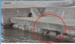
堤体下部コンクリート劣化 (干満帯部)の防護
